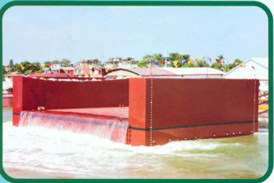
La sección de dique cae al agua de acuerdo a lo planeado.
