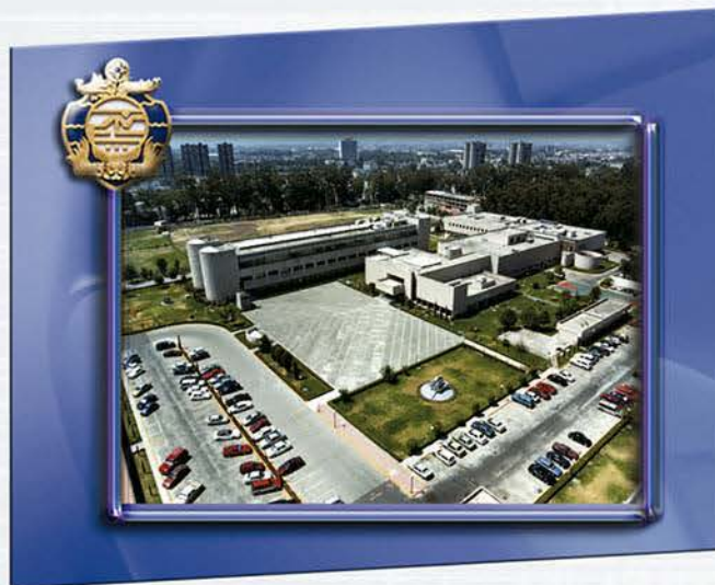
Vista aérea del Centro de Estudios Superiores Navales en su sede actual.
