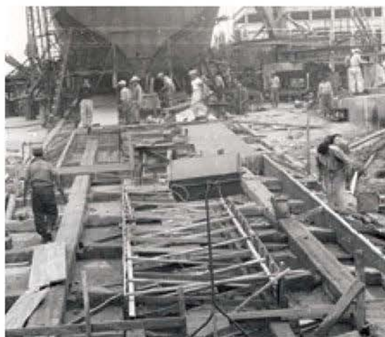
Para construir el Buque México fue necesario acondicionar las gradas de San Juan de Ulúa.
