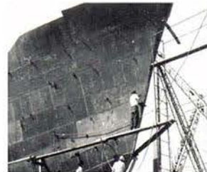
Aspectos de las distintas fases de construcción del buque México.
