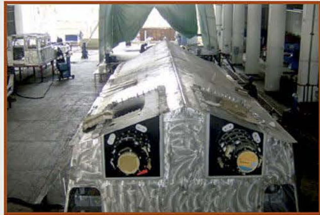
En la grada de ensamble se colocaron los primeros elementos estructurales...
