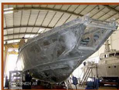
El proceso de producción permite ensamblar dos patrullas al mismo tiempo...
