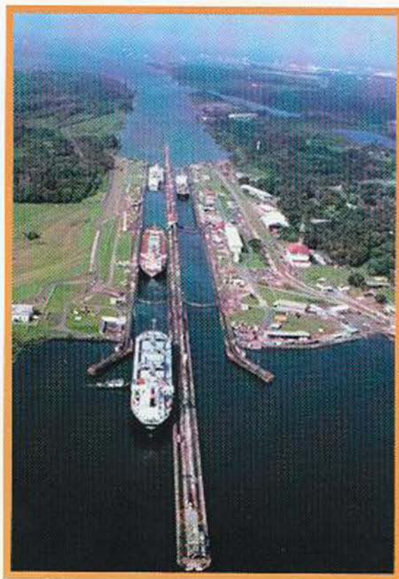
Vista panorámica de las esclusas y represa del lago Gatún, desde donde los buques navegan casi 44 km hasta el extremo norte del corte Gaillard.
