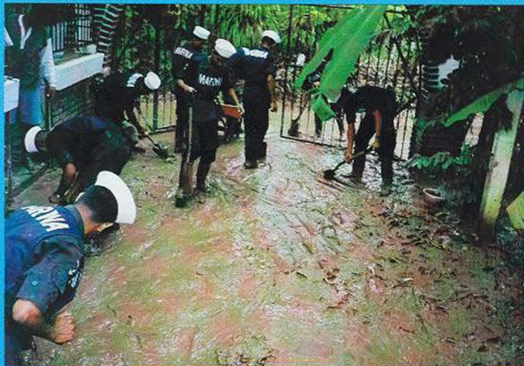
Elementos de la Armada de México ayudan a la población civil mediante la instalación de drenaje y construcción de banquetas en Casitas, Veracruz.
