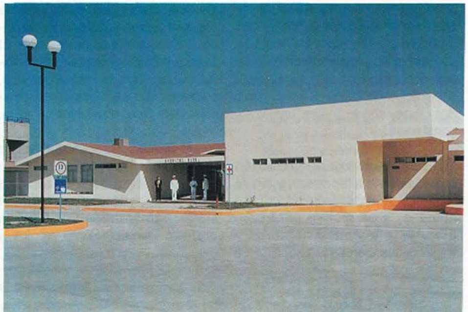
Vista exterior del Hospital de la Base Naval en la II Zona Naval Militar de Ensenada, B. C.
