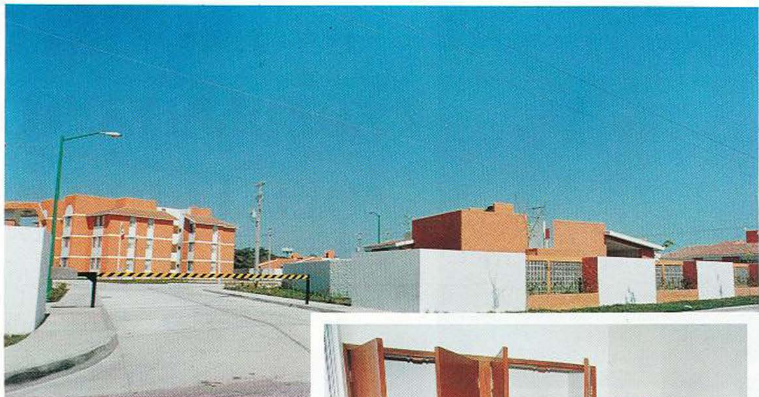
Vista de acceso a la Unidad Habitacional de Frontera, Tabasco.
