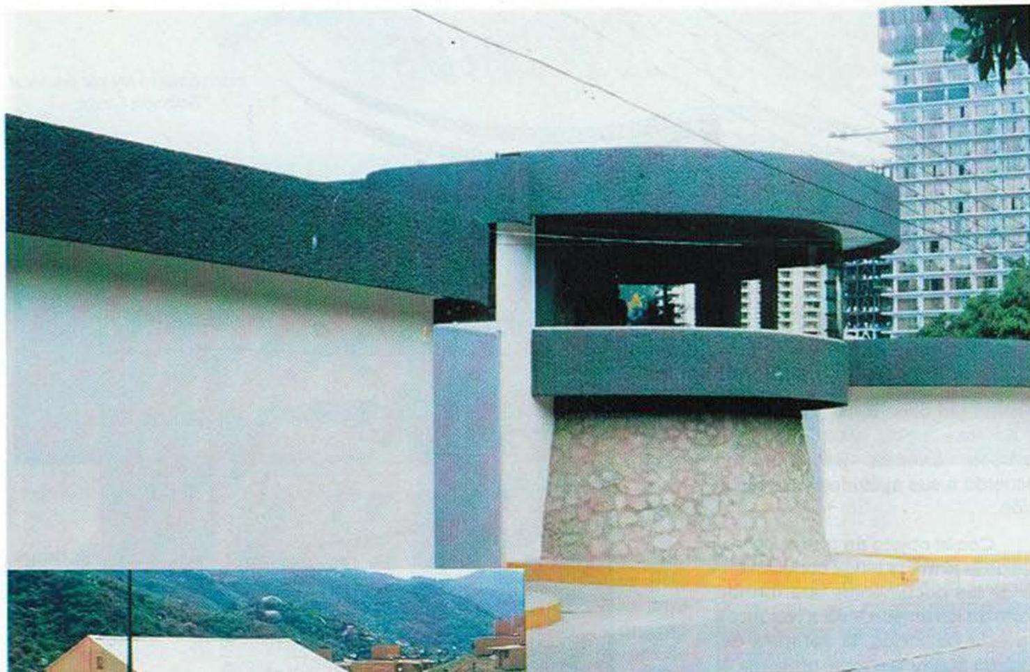
Fachada de acceso a los talleres generales.
