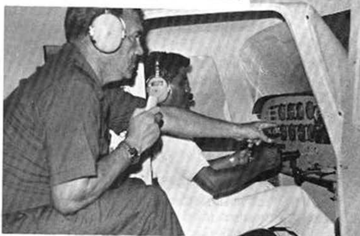
Instructores de vuelo por instrumentos en los simuladores, los cuales contienen los indicadores dispuestos de igual forma que los tableros de los aparatos Cessna C-152 II.
