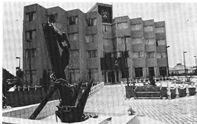
Hotel para Almirantes, Capitanes y Oficiales que transitan por la ciudad de México.
