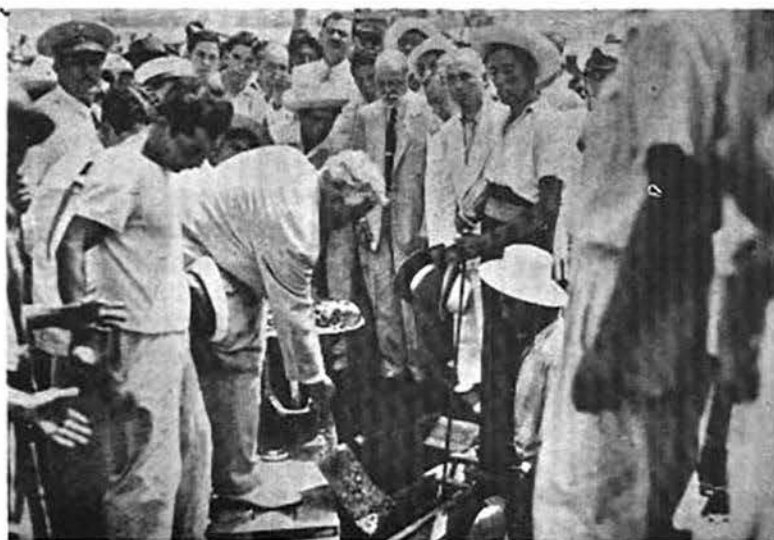
Como uno de los actos conmemorativos del Día de la Marina, el Secretario de Marina, general de división Heriberto Jara Corona, coloca la primera piedra de la Casa del Marino, en un lote ubicado en el costado Noreste del Edificio de Faros, en el puerto de Veracruz, Ver., el 13 de junio de 1942.
