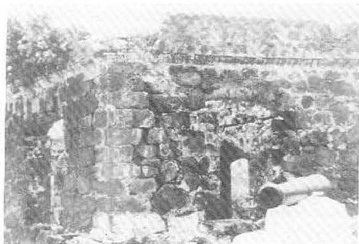
También en el cerro de San Basilio se construyó (en 1770) el fuerte de La Contaduría, que funcionó como oficinas contables durante la colonia.
