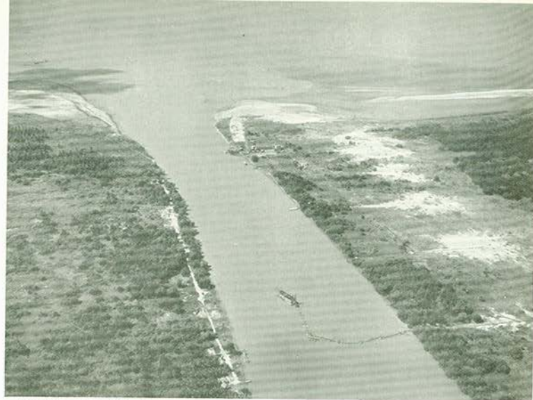
3 Dragado en el canal lateral Dredging in Lateral canal
