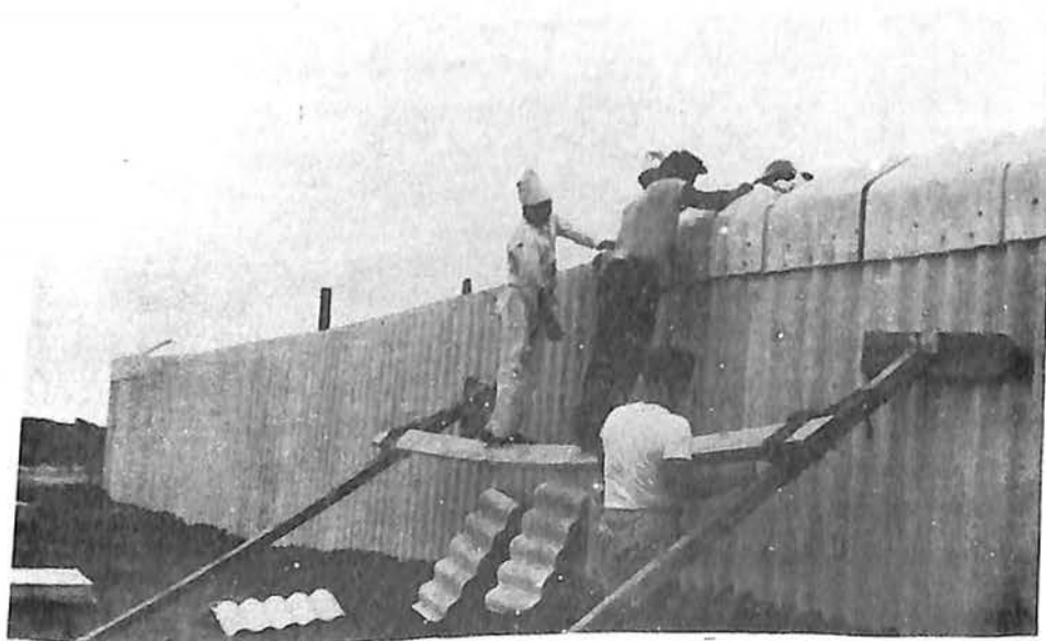
FOTO No. 6.- CASA DE INGENIEROS; VISTA DE LA CONSTRUCCIÓN.
