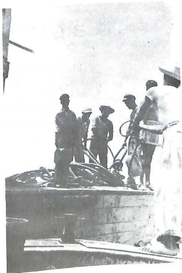
FOTOS Nos. 23 y 24.- UN ASPECTO DE LA PERFORACIÓN EN LA LAGUNA.- SACANDO LAS ANCLAS- PARA CAMBIAR DE POSICIÓN EL CHA · 21
