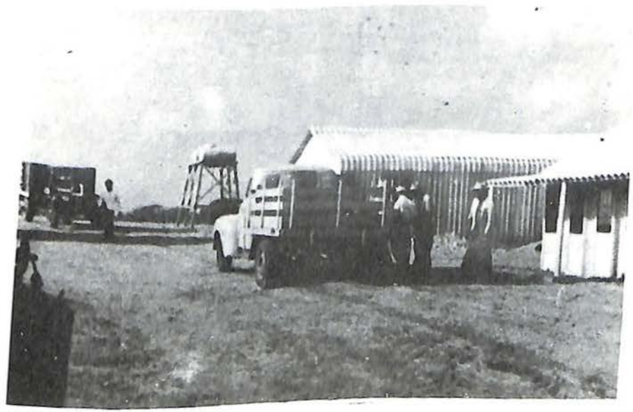
FOTO No. 9°.- OTRO ASPECTO DEL CAMPAMENTO TERMINADO, PUDIENDO APRECIARSE DOS DE LOS VEHÍCULOS Y UN GRUPO DE PEONES.
