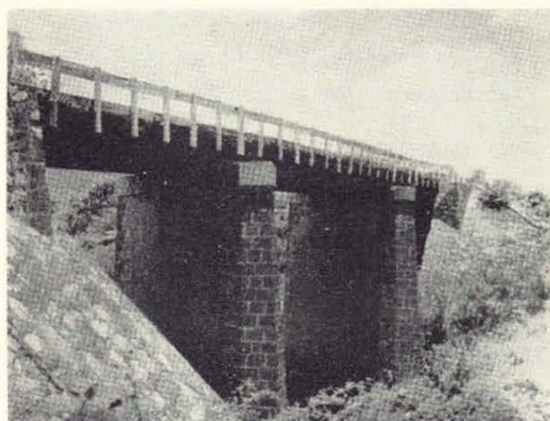
Puente sobre una de las carreteras abiertas al tránsito durante el actual sexenio gubernamental.
