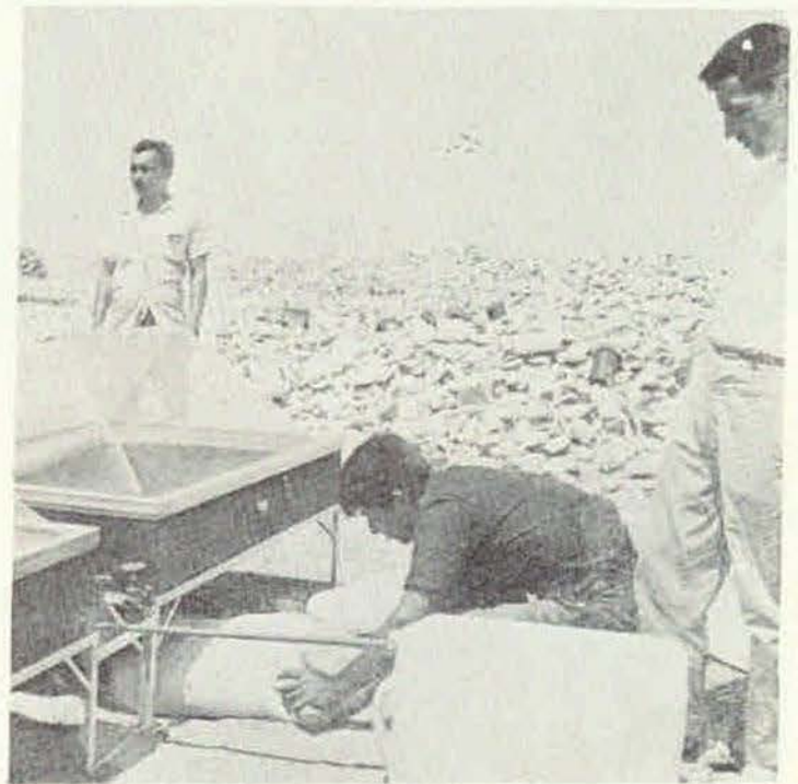
Foto 8.- Otro aspecto del proceso de instalación del Destilador solar en Isla Triangulos Campeche.
