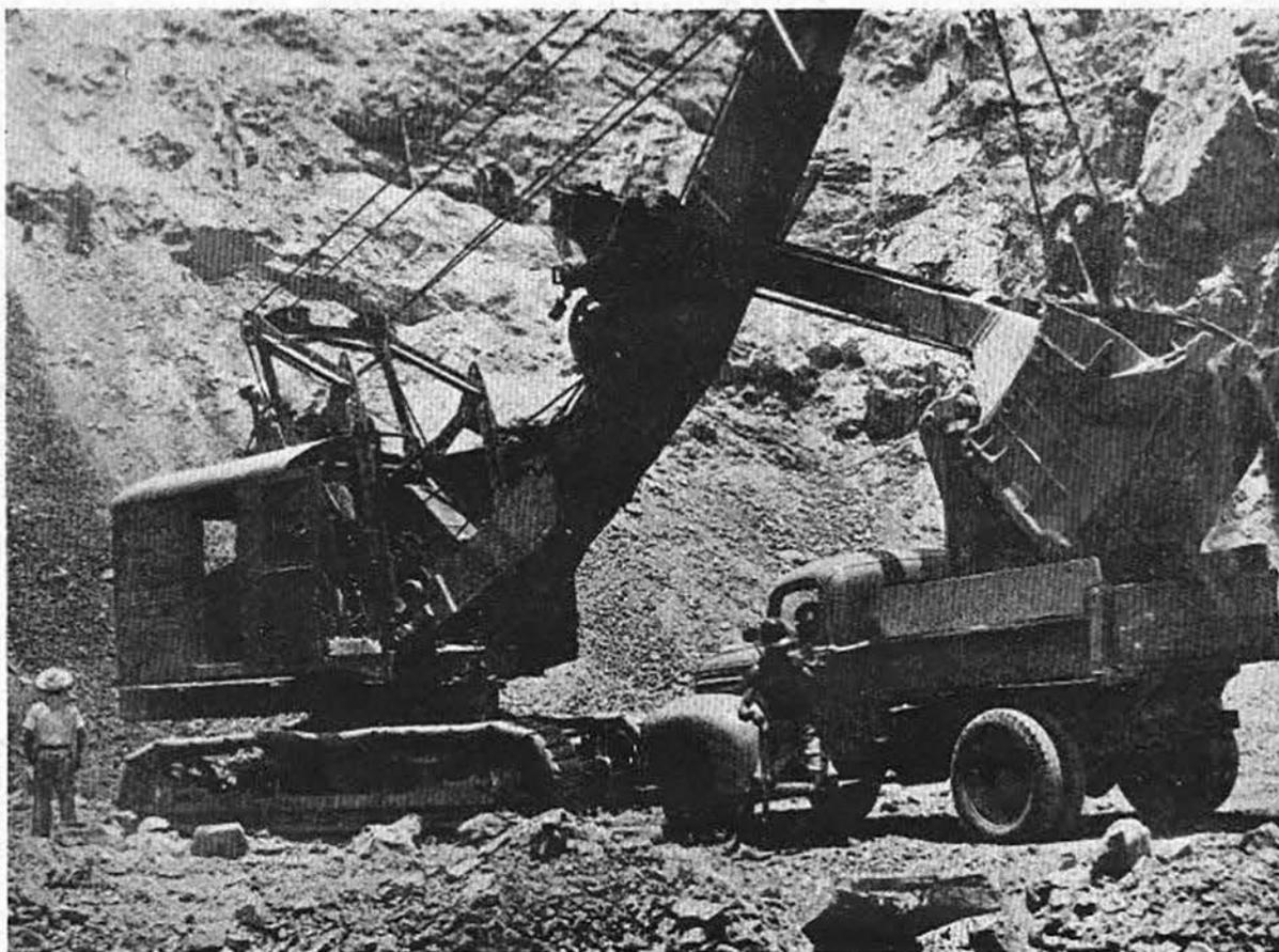
Una de las palas mecánicas en la excavación del tajo del puerto interior de Manzanillo.
