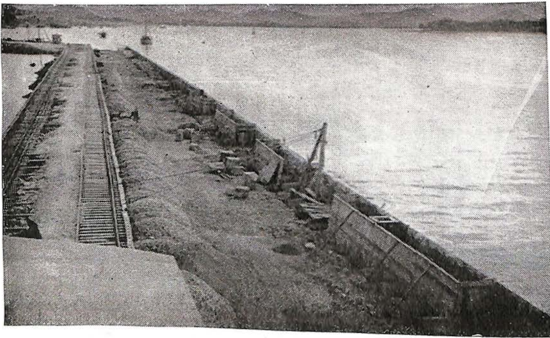
Vista general del malecón de Mazatlán, en construcción.
