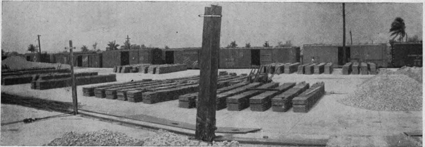
Muelle de Minerales del puerto de Tampico, en plena actividad. Nótese la gran cantidad de minerales ahí depositados listos para las maniobras de carga.
