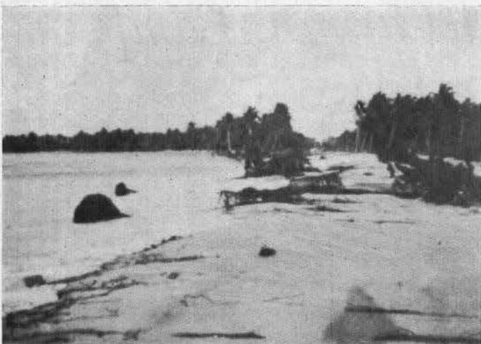
Tramo de Carretera destruido por la acción erosiva del mar.
