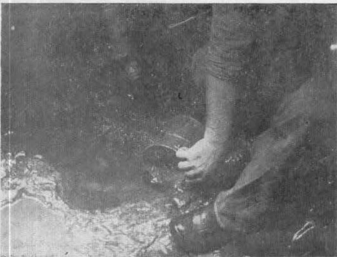
Fig. No. 13.—Maniobra para introducir el fierro de refuerzo en el molde de la pila.
