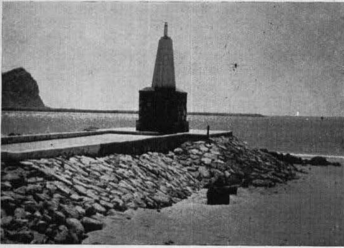
Baliza luminosa, construída en el extremo sur de la escollera del Suroeste. Mazatlán, Sin.
